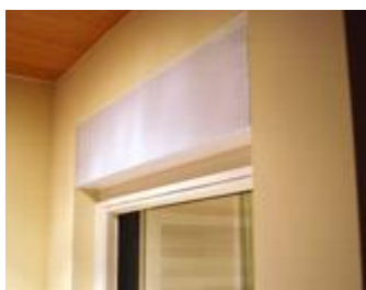
opbouwrolluik binnenzijde kast op raam gebouwd kastdoorsnede
