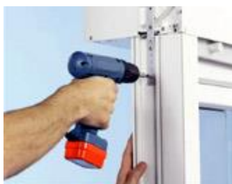
opbouwrolluik binnenzijde kast op raam gebouwd kastdoorsnede
