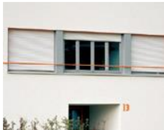
Discreet ingewerkt in de gevel
